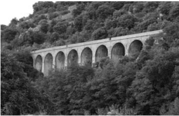
Viaduc du Lunet 107 m, 10 arches.
