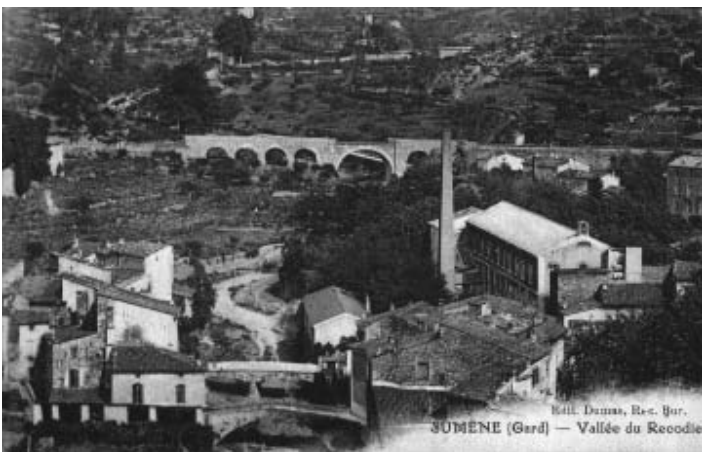
Viaduc du Recodier à l'est de la ville de Sumène.
