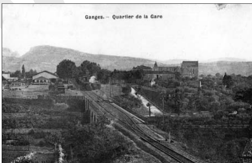
Ganges - Sumène : viaduc de 91 m à la sortie de la gare au Puech.
