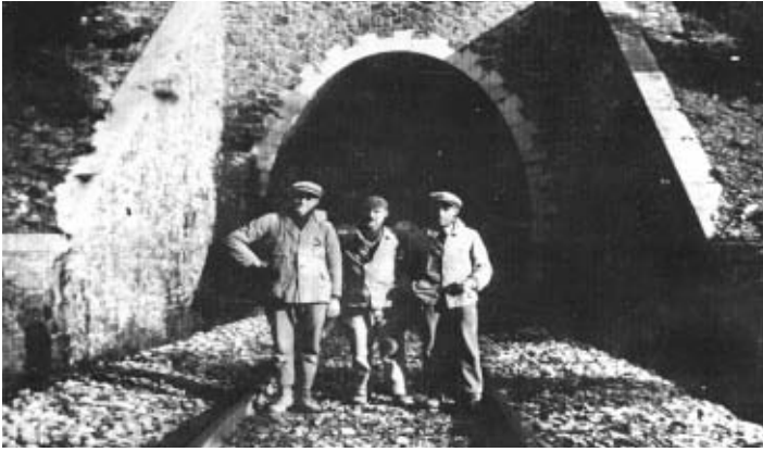
Ouvriers à l'entrée d'un tunnel.
