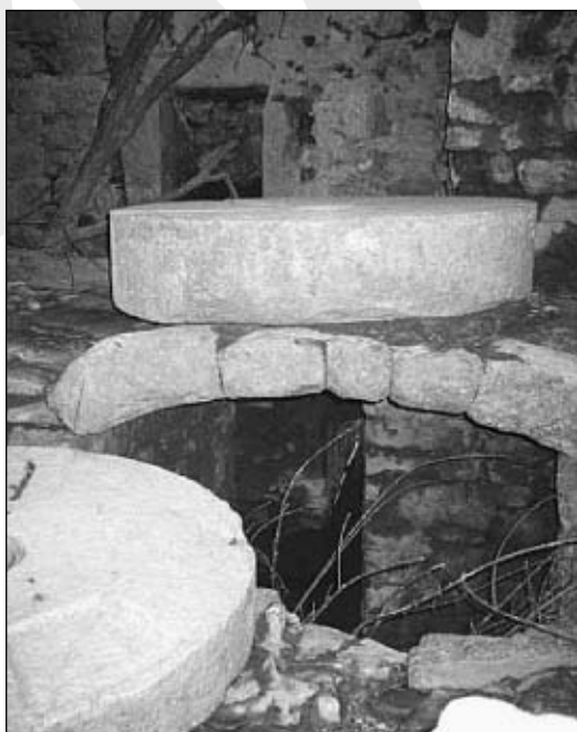
Intérieur de moulin fortifié de Figuières.
