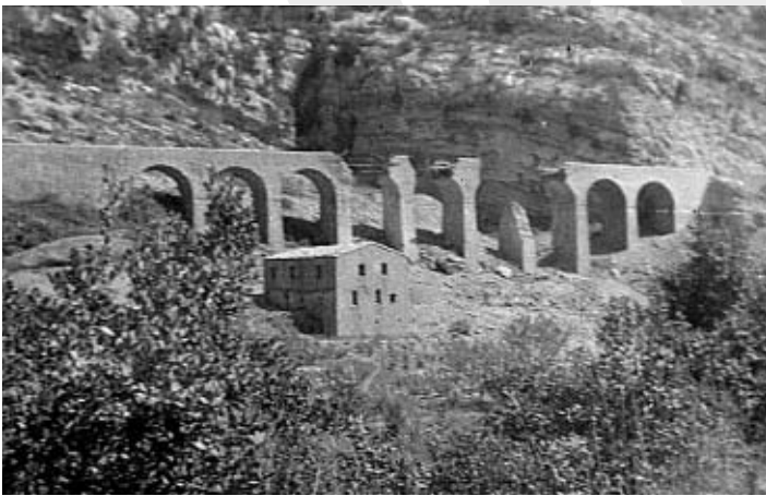
Viaduc de 97 m, après le Pont des Chèvres, bombardé en 1944.
